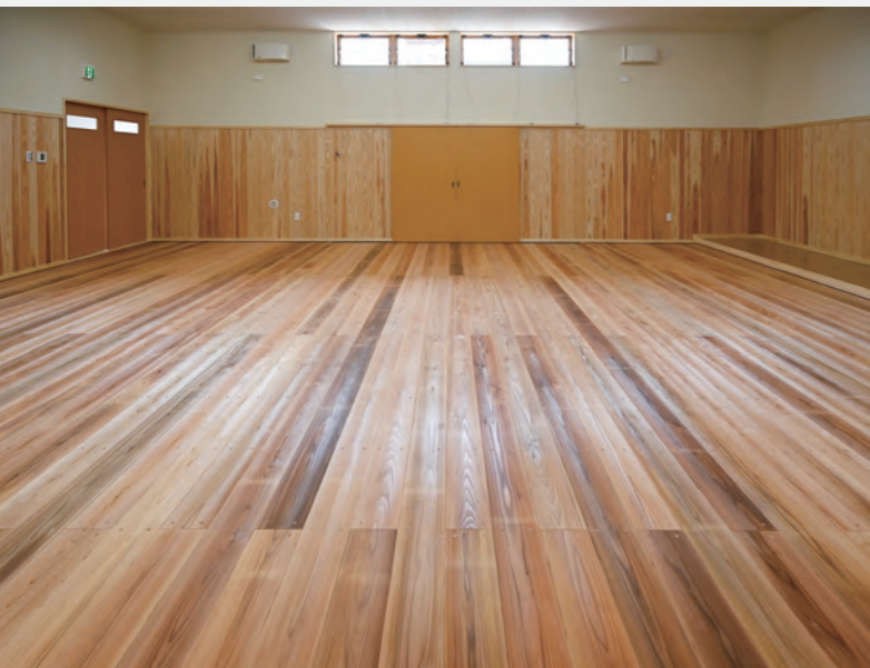
写真10 弾性剣道場床施工例 (個人所有の剣道場 (8m x 8m))
