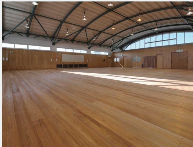
写真9 弾性剣道場床施工例 (栃木県矢板中央高等学校剣道場)
